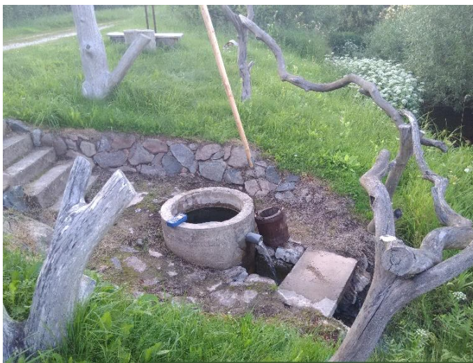
10 pav. Barklainio šaltinio ištaka pertvarkyta – vandens surinkimui sumontuotas šulinėlis, iš jo nuolat teka vanduo
